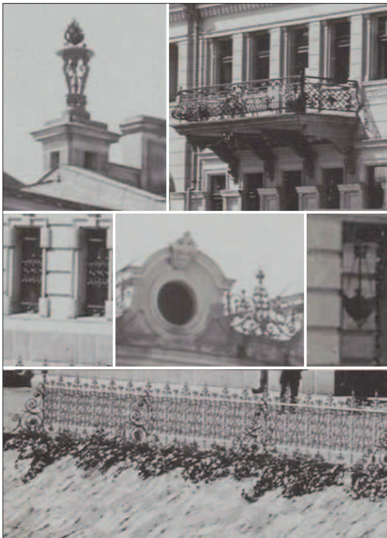
33. Ciąg dalszy zbliżeń na detale. Metaloplastyka: motyw ogni wiecznych/latarnie sławy, na zwieńczeniach szczybów wentylacyjnych nadscenia, balkon z balustradą na wzorach osiemnastowiecznych (kratki regencyjne, liście akantu), kraty w oknach parteru, obudowy ochronne dachu, lampa podjazdu, krata przy rzece od Alfreda Milkego. / Wycinki fotografii nr 27.
