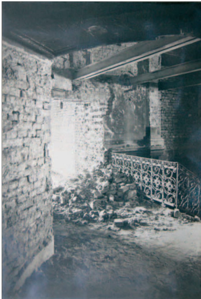
37. Unikatowa fotografia z około 1935 roku, przedstawiająca przejście z widowni do południowo-zachodniej klatki schodowej [flankującej segment z foyer] na wysokości pierwszego piętra. Widoczna zachowana balustrada metalowa schodów i elementy pierwotnego (?) wystroju – pilaster, gzymsy, kolorowe pola malowania ścian. Widoczny proces przebudowy/odbudowy teatru, z dostawieniem nowych segmentów (wykute przejście, zmieniony kształt klatki schodowej). / APK, Spuścizna Tadeusza Martyna, sygn. 1425, s. 6.
